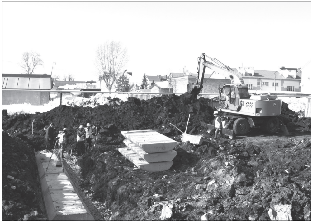
На ул. Красноармейская, 65 начались фундаментные работы. Фото автора.
